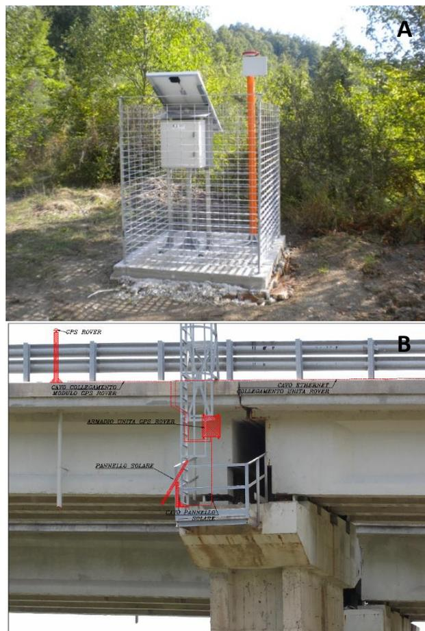
Figura 4 – A. Stazione rover ubicata in frana; B. Schema di stazione rover ubicata sul viadotto.
